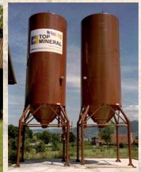
Siloanlage 29m 3 , Golfpark Holzhäusern Ausführung mit zusätzlich elektr. Füllstandsmelder
